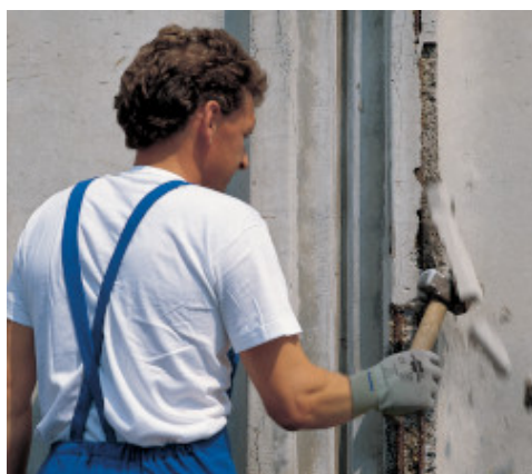
Fjernelse af nedbrudt beton
